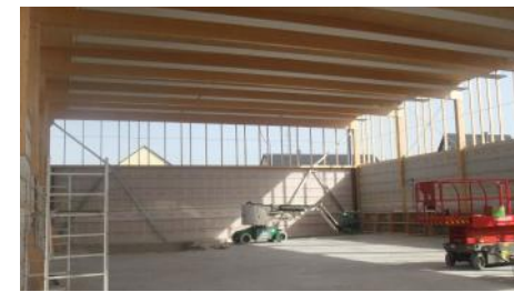
Phase travaux (salle de gymnastique)
