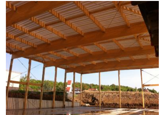
Vue intérieure sur charpente et couverture
