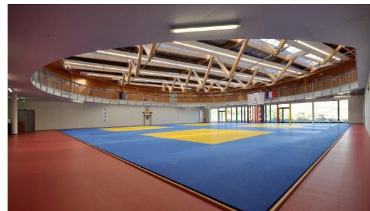
Vue intérieure : charpente BLC sur grand dojo
