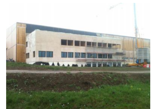
Façade avant des bureaux
