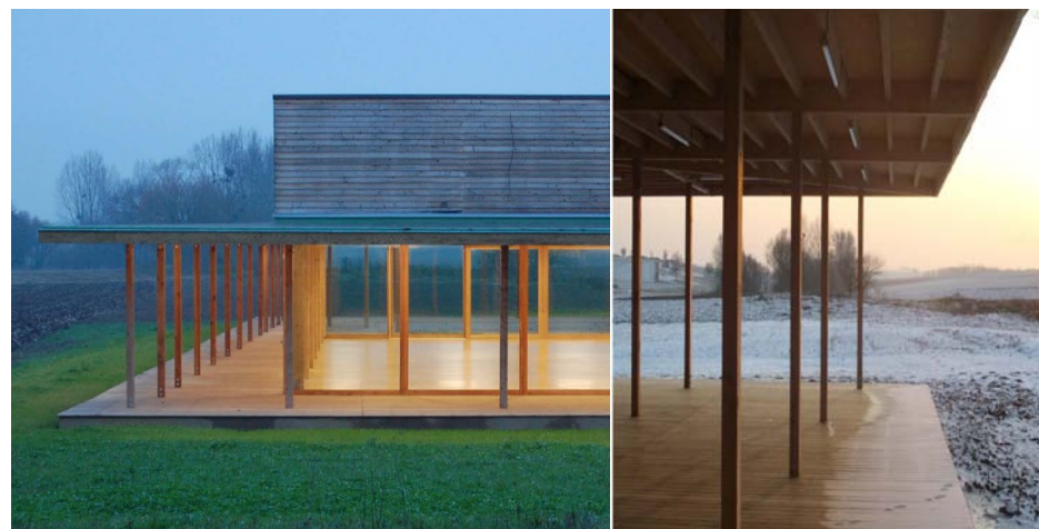
Vues extérieures sur la grande salle et le parvis
