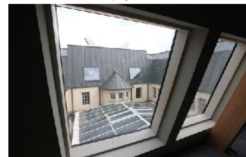
Vue sur verrière (façade intérieure Nord)
