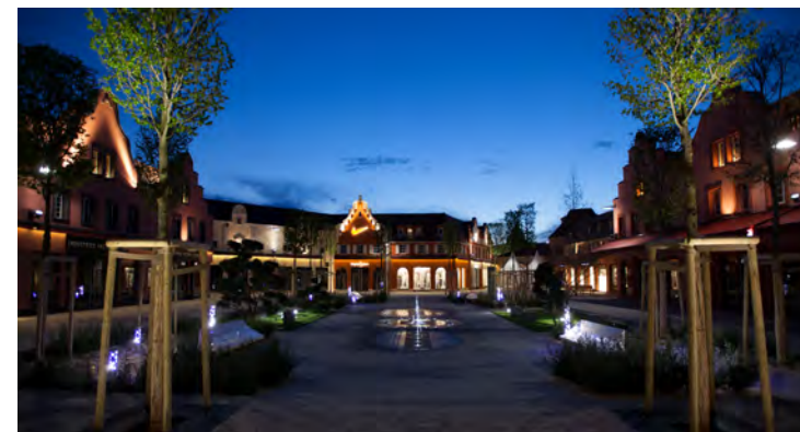
Vue de l'ensemble du projet
