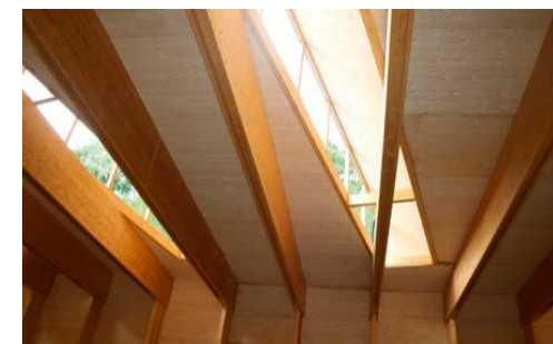
Vue intérieure sur portiques BLC, toiture CLT et lanterneaux
