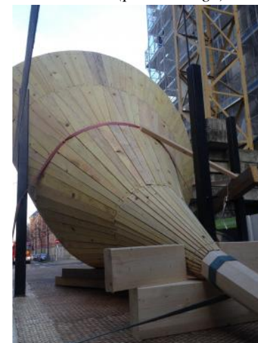
Tourelle (phase levage)
