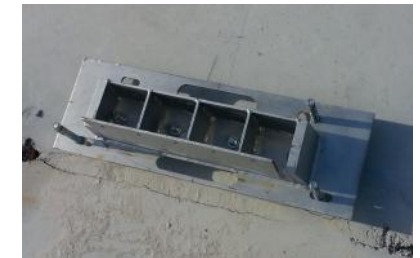
Créneau métallique entre les voiles CLT et la dalle BA
