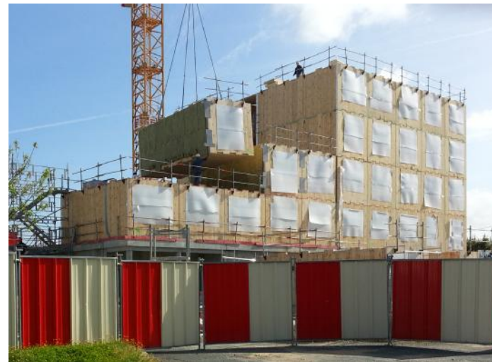
Photo prise lors du montage des modules 3D sur site
