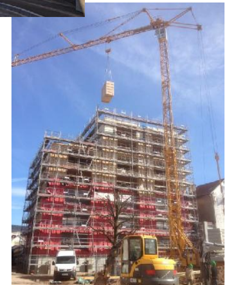
Bâtiment A en cours de pose (photo Sertelet)
