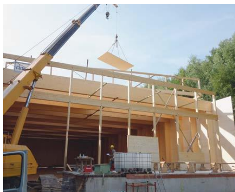
Montage d'un panneau CLT de toiture
