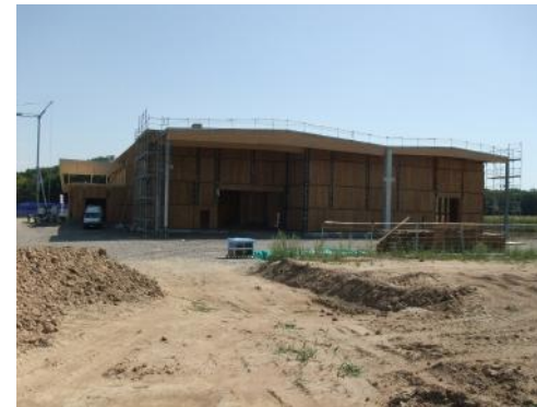
Ossatures et bardage bois en cours de pose
