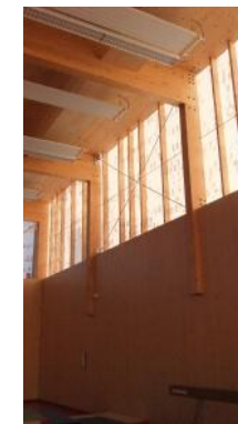
Vue intérieure (salle de gymnastique)
