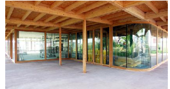
Entrée principale de la salle polyvalente
