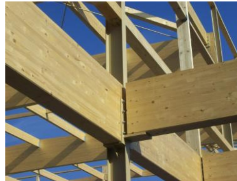
Jonction poteau métallique – poutres BLC
