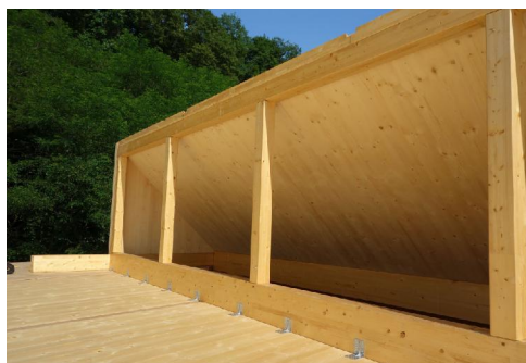
Vue sur un lanterneau BLC / CLT
