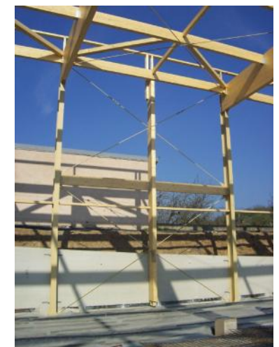
Palée de stabilité longitudinale (façade Nord - Ouest)
