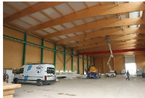
Vue d'ensemble sur la charpente du hall de production
