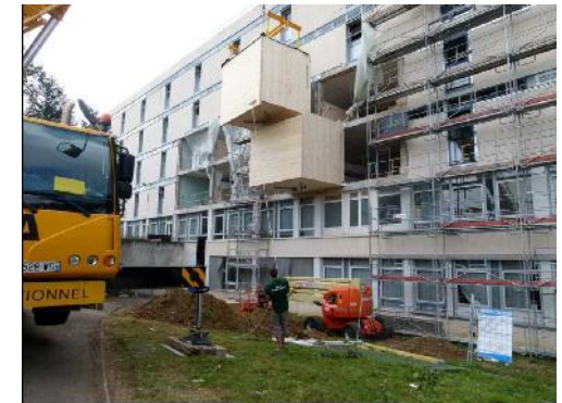
Pose d'un module préfabriqué
