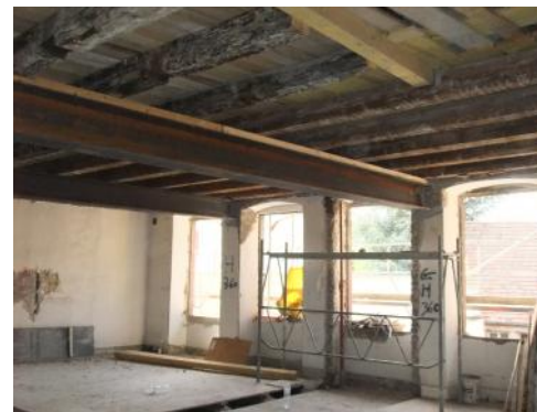
Sous-poutres métalliques – Bâtiment A
