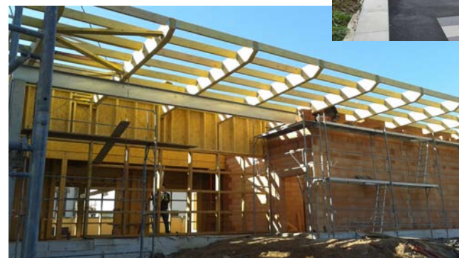
Vue sous l'auvent en phase chantier
