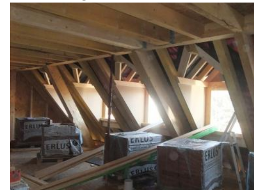
Charpente BLC – Bâtiment A
