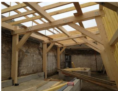
Fermes autostables (angle Ouest)
