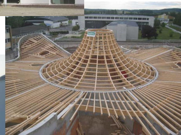
Vue extérieure en toiture
