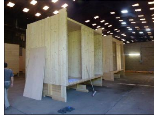
Blocs en panneaux CLT assemblés en usine
