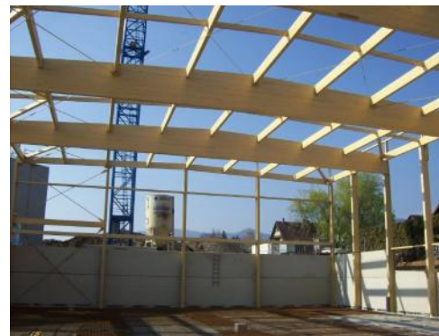
Arbalétriers BLC à inertie variable (classe GL32c)
