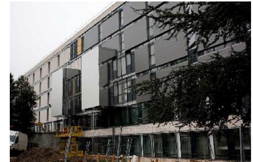
Façades avec bardage métallique
