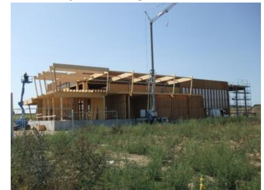
Montage de la charpente des halls
