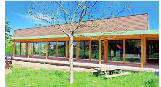
Vue sur auvent extérieur et façade vitrée
