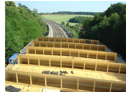
Vue extérieure sur la toiture CLT
