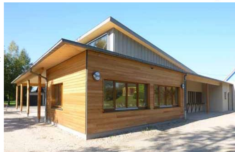
Vue extérieure (angle Sud - Est)
