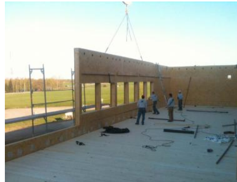
Montage des bureaux
