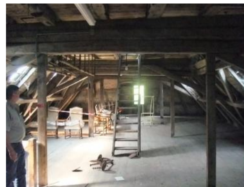
Charpente conservée et renforcée – Bâtiment C
