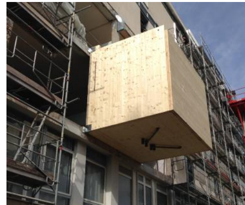
Fixation par ferrures contre l'existant
