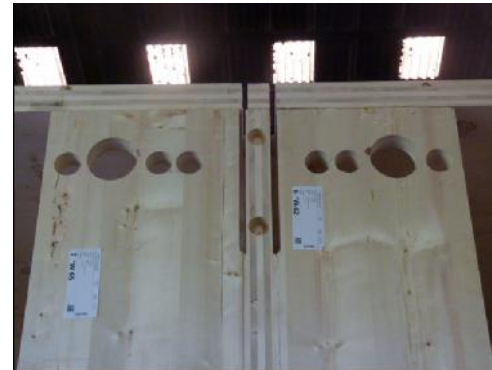
Préperçage en usine pour passage des gaines
