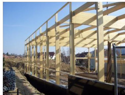
Acrotères et poteaux pendulaires (façade Nord - Ouest)
