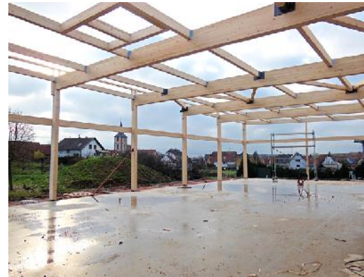
Montage de la charpente (salle polyvalente)
