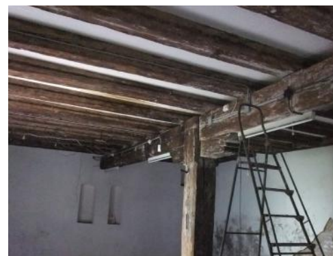
Plancher RdC préservé – Bâtiment B
