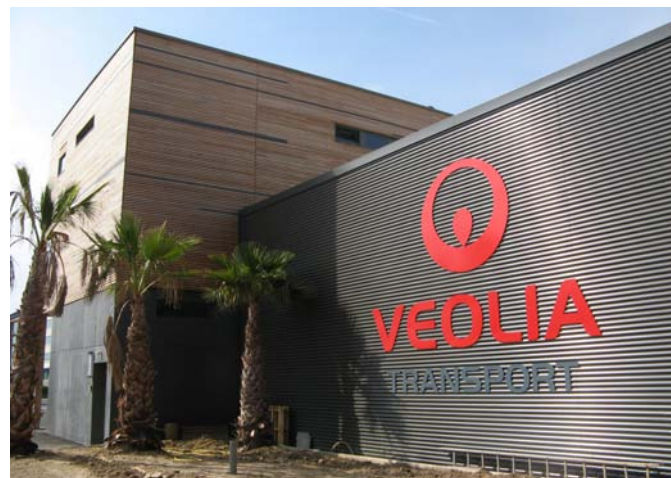
Vue extérieure (angle Nord-Est)
