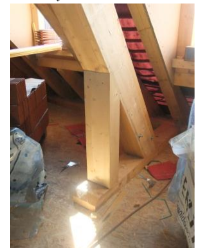
Pied de ferme BLC – Bâtiment A
