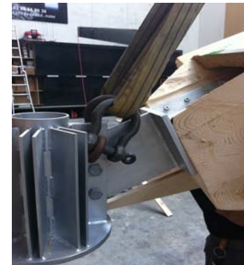
Photo en atelier : essai de levage des ferrures en têtes des poteaux métalliques
