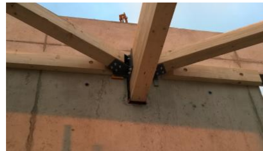
Ferrures entre arbalétriers et diagonales bois
