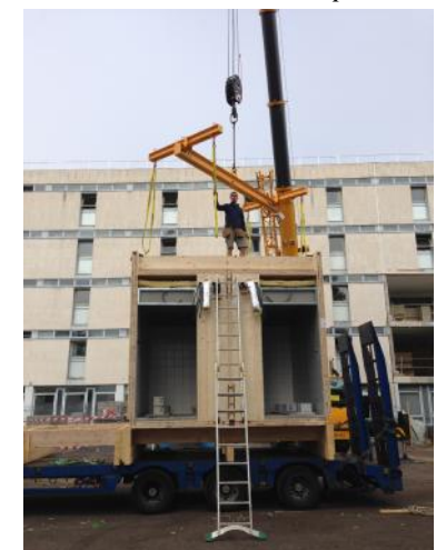
Vue sur un bloc avant pose
