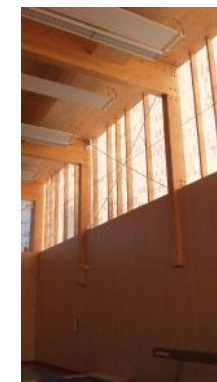
Vue intérieure (salle de gymnastique)
