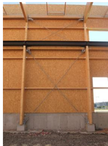
Poutre de roulement et palée de stabilité
