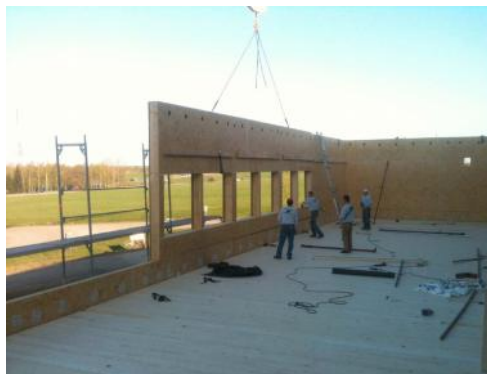
Montage des bureaux
