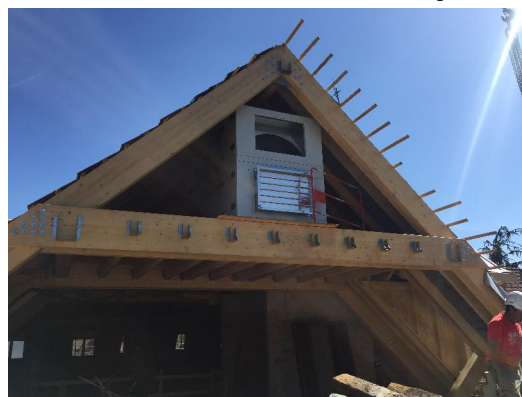
Charpente de toiture (phase travaux)
