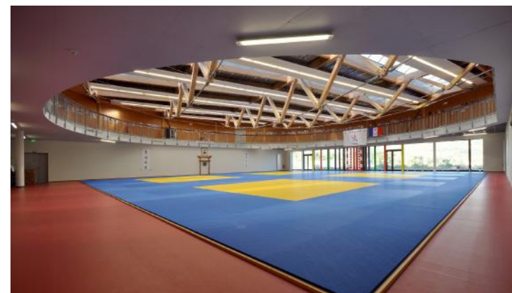
Vue intérieure : charpente BLC sur grand dojo
