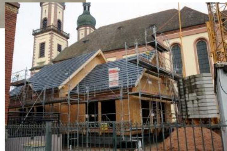
Vue extérieure chantier en cours, tuiles posées, sans parement brique
