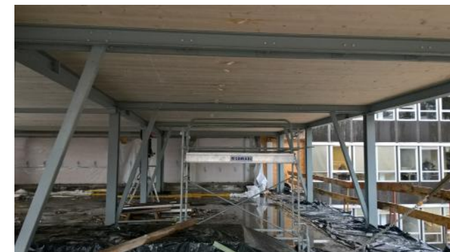
Phase chantier: Portiques métalliques + plancher CLT
