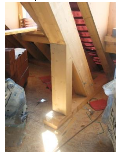
Pied de ferme BLC – Bâtiment A
