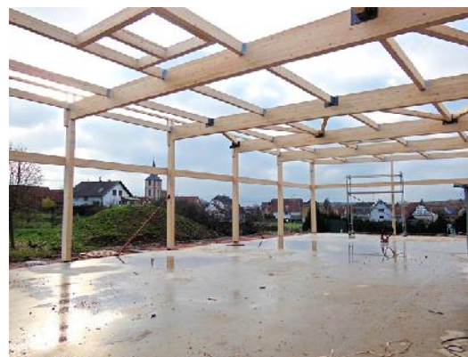
Montage de la charpente (salle polyvalente)
