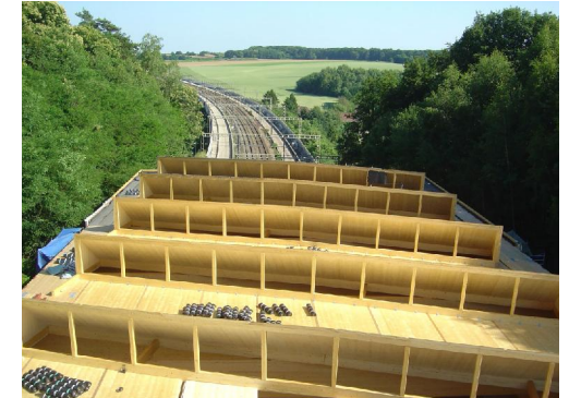
Vue extérieure sur la toiture CLT
