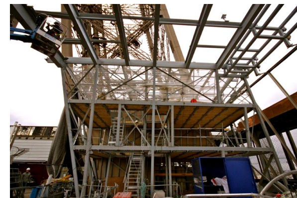
Vue sur les planchers CLT (phase travaux)
