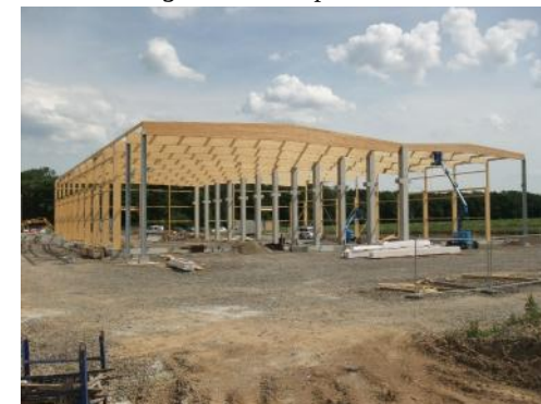
Montage de la charpente des halls
