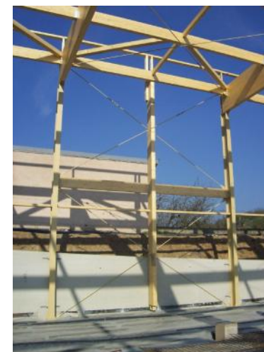
Palée de stabilité longitudinale (façade Nord - Ouest)
