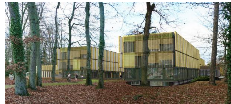
Perspective arrière sur le bâtiment - réhabilitation et extension (Phase 2)
