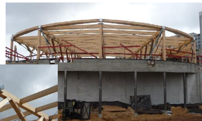
Vues en cours de montage de la charpente
