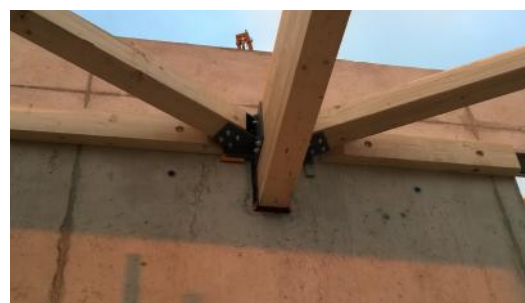
Ferrures entre arbalétriers et diagonales bois
