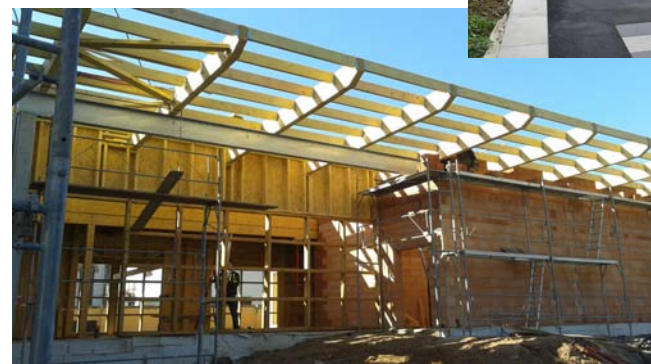
Vue sous l'auvent en phase chantier
