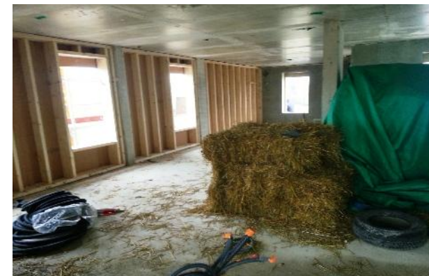
Vue intérieure en phase chantier : MOB posé, en attente de la paille
