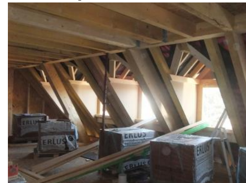
Charpente BLC – Bâtiment A
