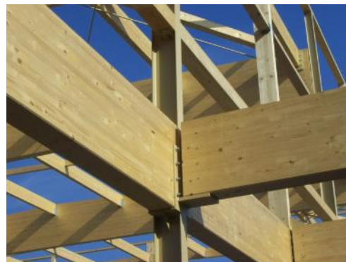
Jonction poteau métallique – poutres BLC
