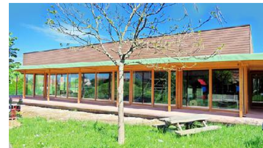
Vue sur auvent extérieur et façade vitrée
