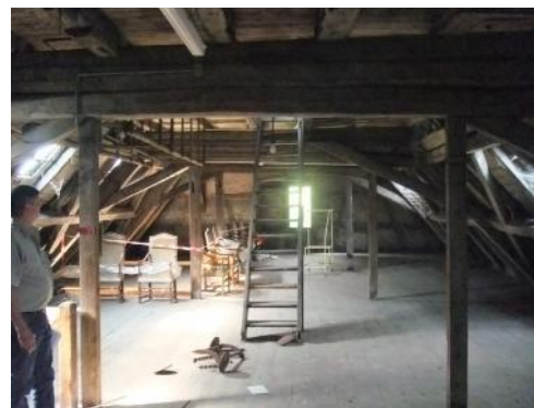
Charpente conservée et renforcée – Bâtiment C
