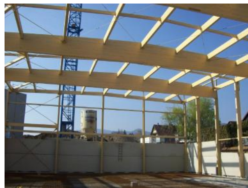
Arbalétriers BLC à inertie variable (classe GL32c)
