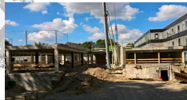
Phase chantier: Mise à nu de l'ouvrage existant
