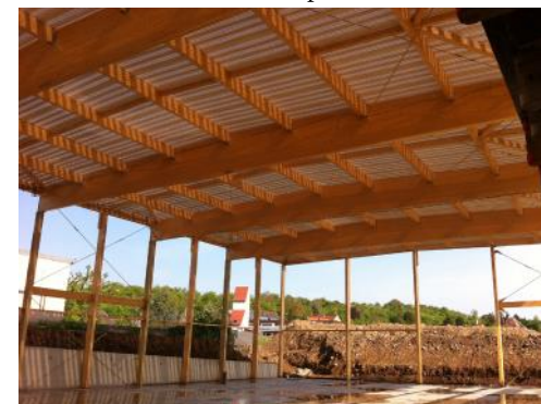
Vue intérieure sur charpente et couverture
