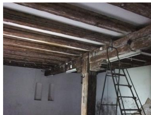
Plancher RdC préservé – Bâtiment B
