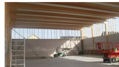
Phase travaux (salle de gymnastique)
