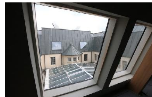
Vue sur verrière (façade intérieure Nord)
