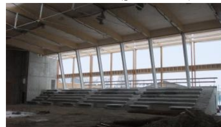
Phase travaux (grande salle)
