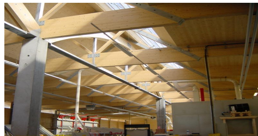
Vue intérieure (hall de fabrication)
