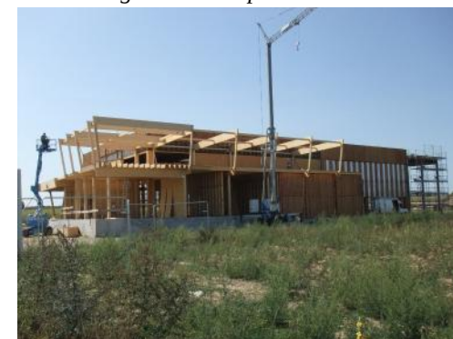
Montage de la charpente des bureaux
