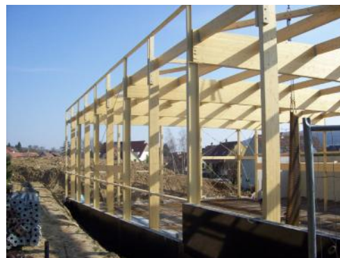
Acrotères et poteaux pendulaires (façade Nord - Ouest)
