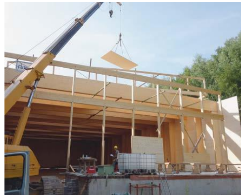
Montage d'un panneau CLT de toiture
