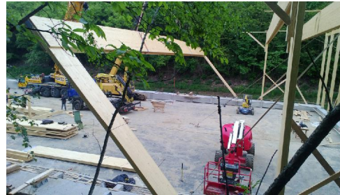
Montage d'un portique BLC
