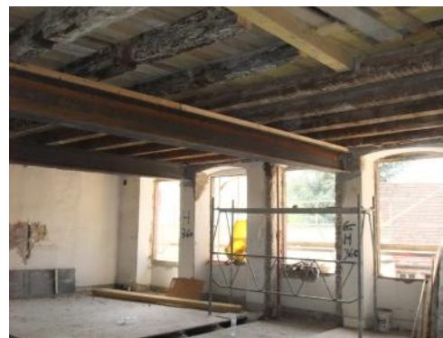
Sous-poutres métalliques – Bâtiment A
