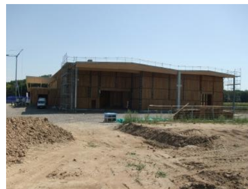
Ossatures et bardage bois en cours de pose
