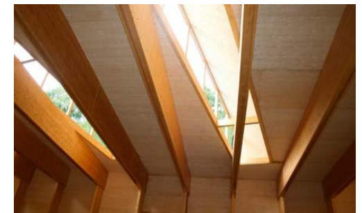
Vue intérieure sur portiques BLC, toiture CLT et lanterneaux
