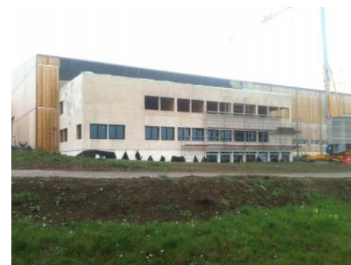
Façade avant des bureaux
